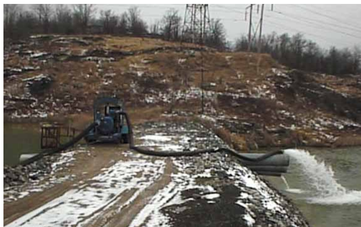
La pompe Thompson Pump à compresseur et auto-amorçage à sec de 6 po a assuré la recirculation de l'eau à forte acidité et du mélange de chaux pour maintenir le pH.
