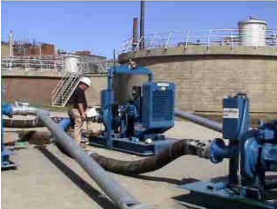
Un travailleur supervisant plusieurs pompes d'aspiration diesel Thompson.
