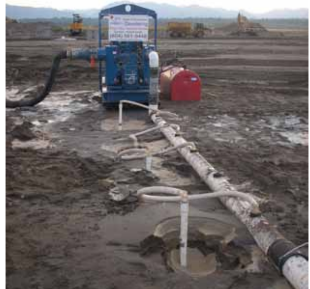
Pompe à pointes filtrantes diesel raccordée à un collecteur et à des tubes flexibles.
