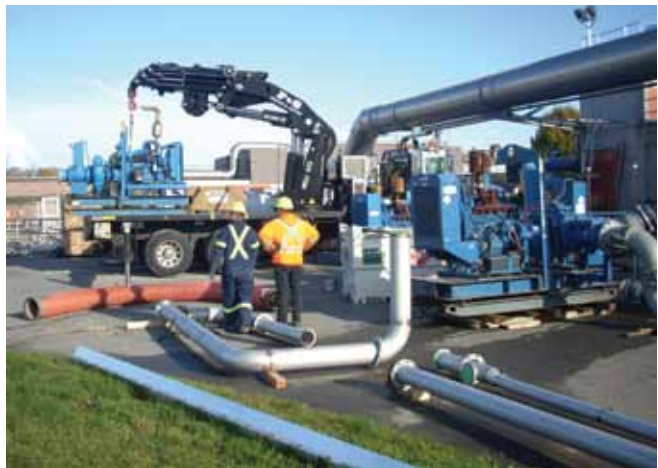
Déchargement des pompes à moteur diesel Thompson et assemblage des conduits d'évacuation sur place.
