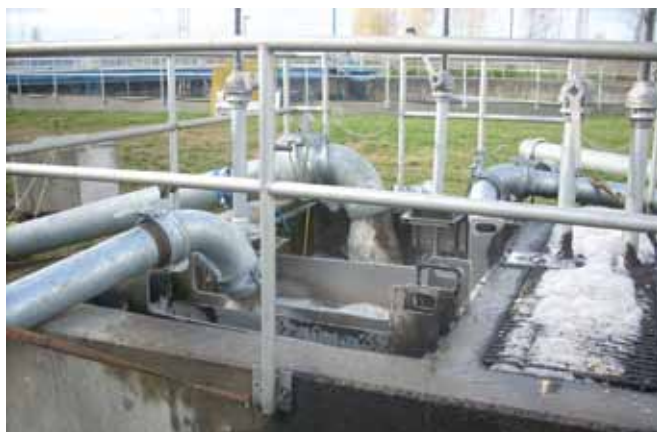
Conduits d'acier Kwik-Lok de 12 po pour la dérivation des égouts.
