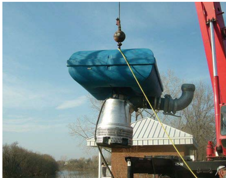
Module de flottaison PFM 1150 et la pompe BS 2250 Flygt en cours d'installation.
