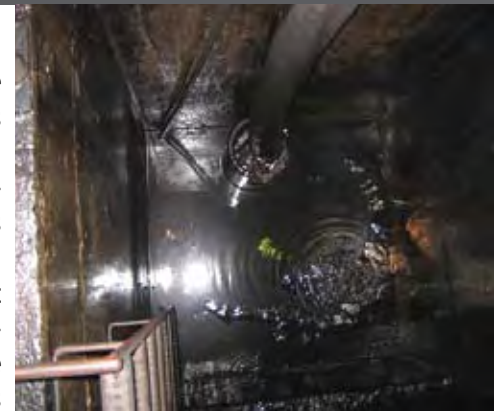
Puisard de lessivage d'étage
