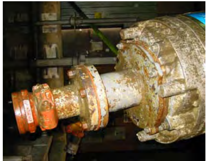
Montage en tandem conçu par le service des ventes de Flygt à Sudbury et nécessaire pour raccorder la pompe au bac de transfert.
