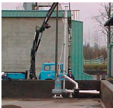
Descente des unités dans le digesteur.
